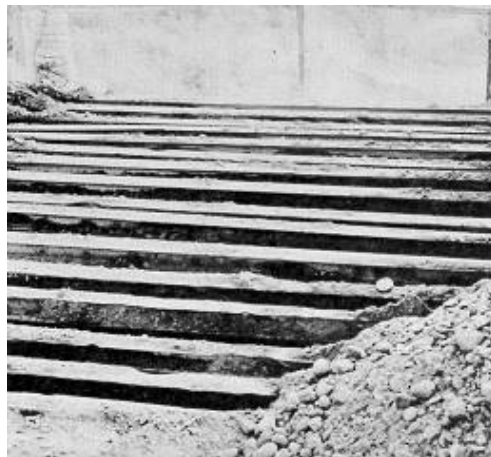
Emparrillado dispuesto sobre la tolva de recepción de áridos
