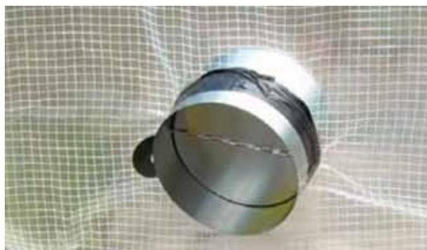
Figura 2. Compuerta anti-retorno
